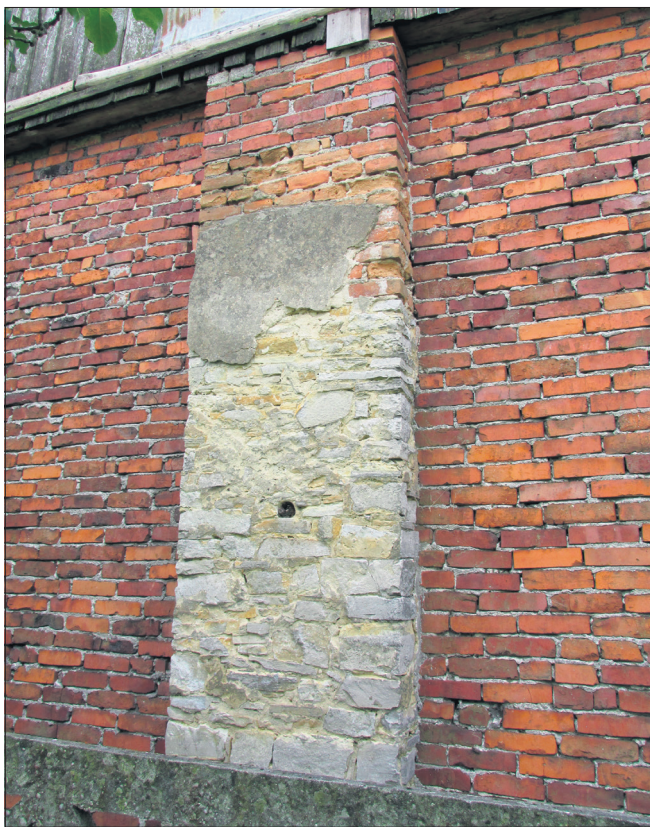
Filar stodoły rodziny Fitz, która spłonęła w marcu 1945 r. Ceglana część filaru to nadbudówka wykonana przy odbudowie stodoły po pożarze. Fot. R. Hellfeier.
